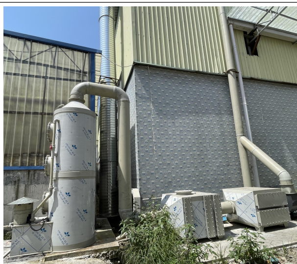
“旋流塔+干式过滤器+活性炭吸附”装置
